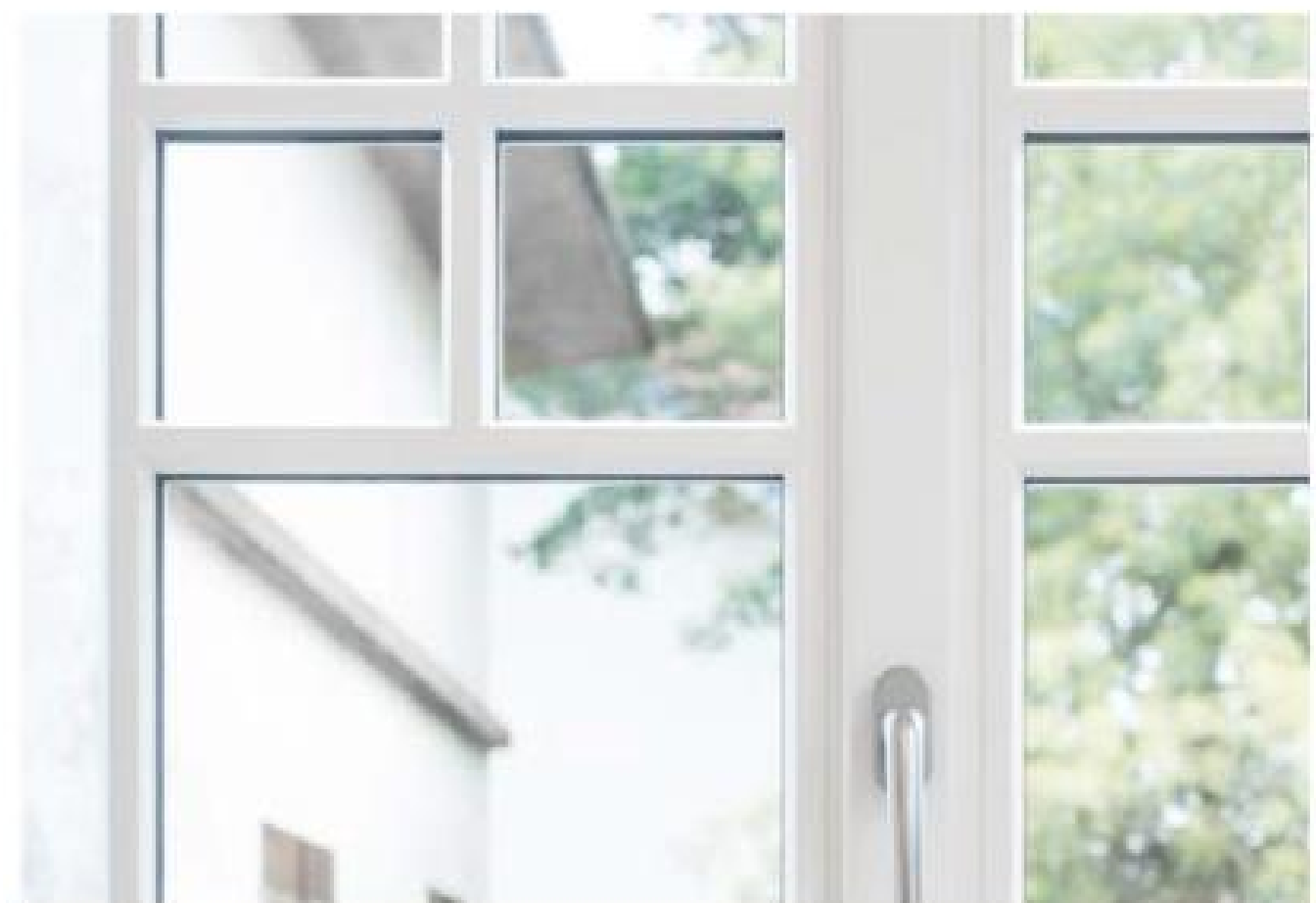
Pan coupé façon solin de mastic
