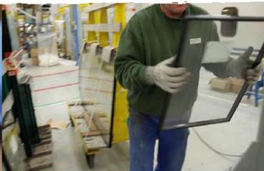
Mise en place du double vitrage
