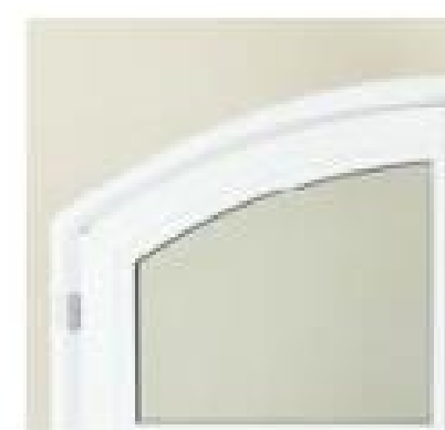
Cintre en arc surbaissé (vue intérieure)
